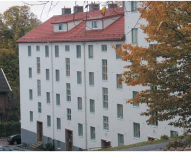
Uteluftsventiler i fasad
